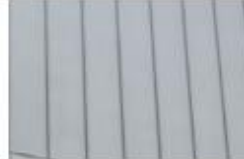
Toiture en zinc
