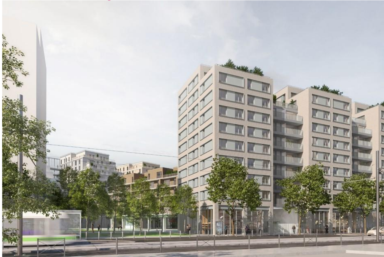
BÂTIMENT B (vue depuis l'Avenue de Stalingrad)
