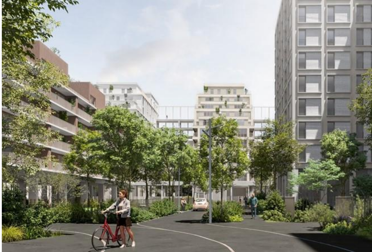
BÂTIMENT A et D (vue depuis l'entrée de l'Opération)
