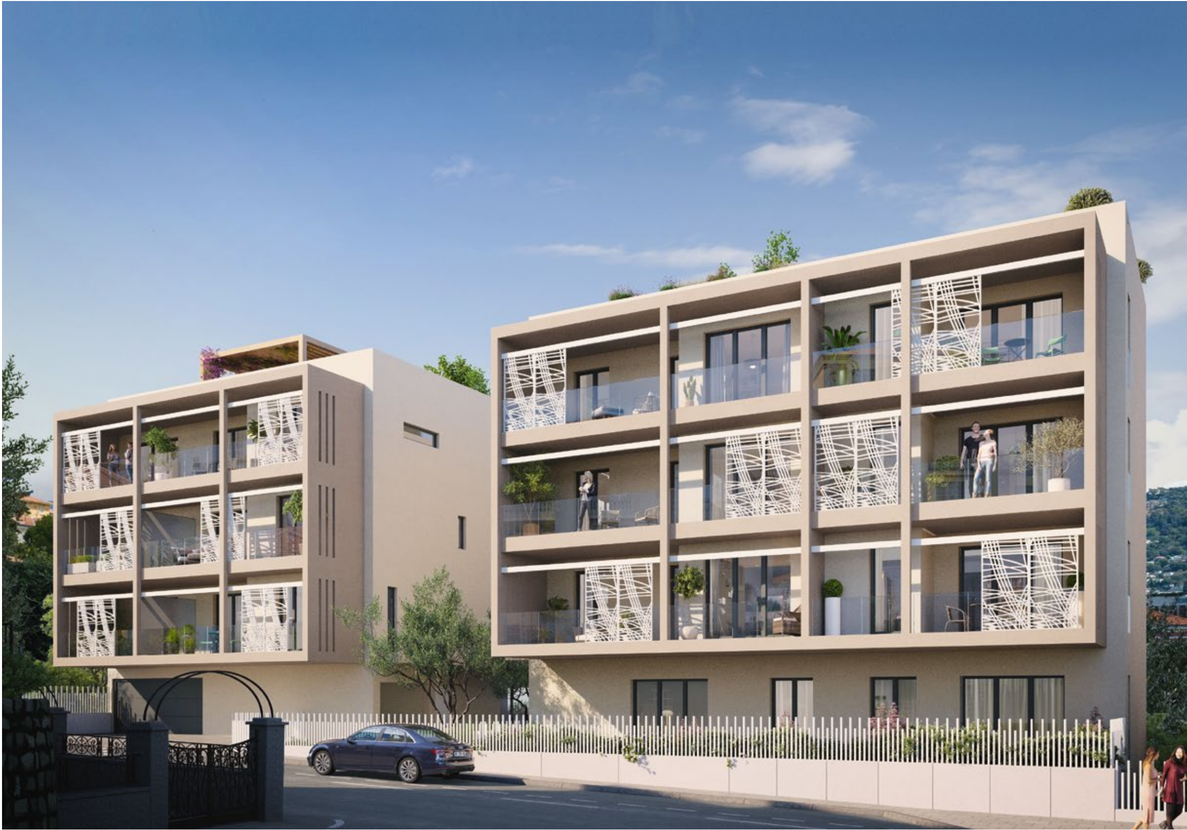
Vue de la résidence depuis l’avenue des Arènes de Cimiez
